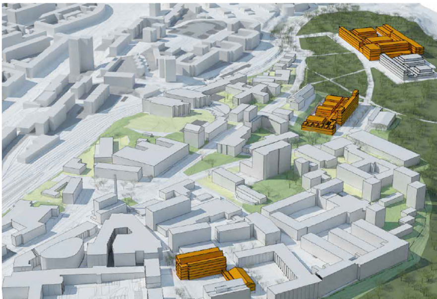
Byggnader där ITM har verksamhet och som berörs av projektet
