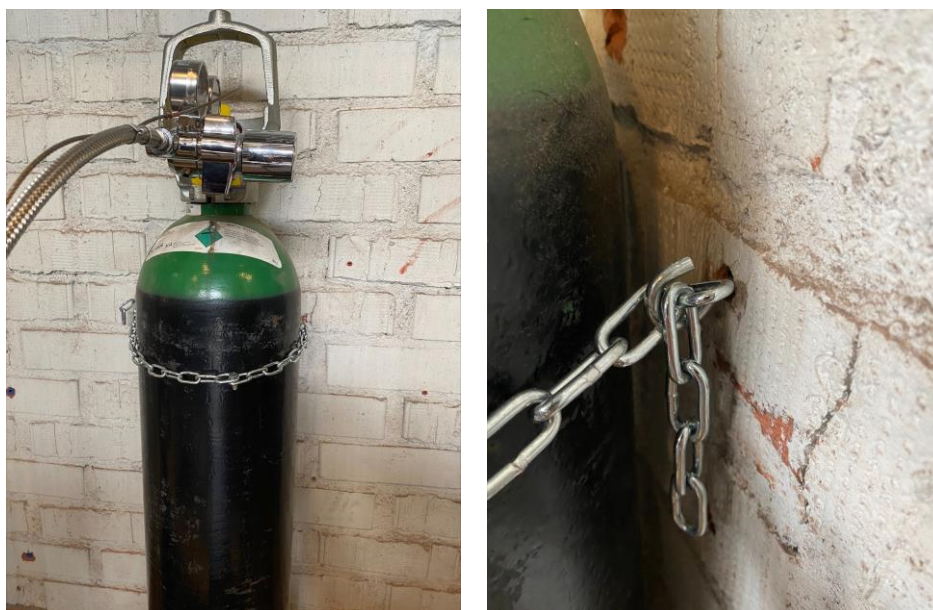
Figur 5. Exempel på hur en gasflaska är säkrad.
