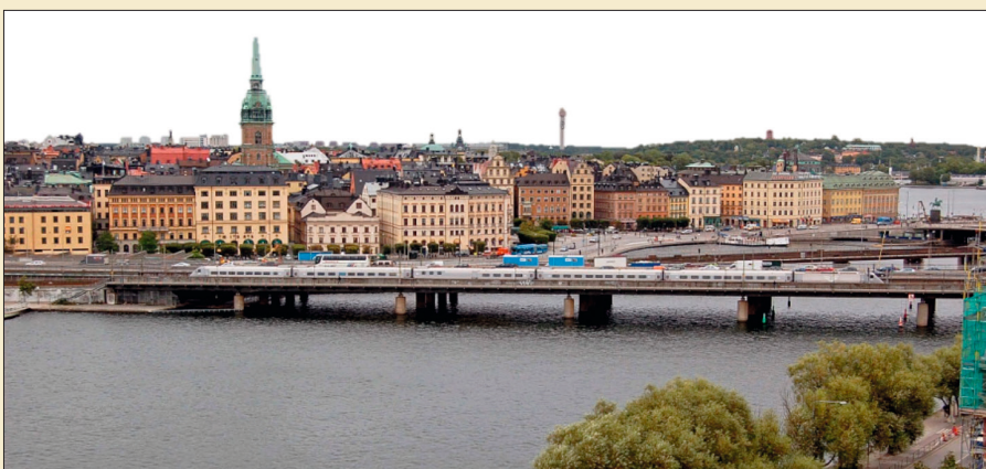
Som studieobjekt används Söderströmsbron mellan Ridderholmen och Södermalm vid Slussen i Stockholm, från omkring 1952. Med 572 tågpassager per dag är den Sveriges viktigaste järnvägsbro.
