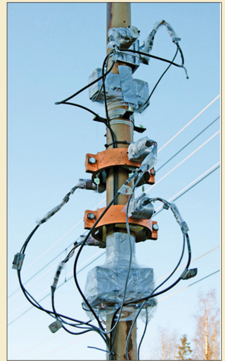
Prototyp av KTH dämpare som monterats på en av hängarna till bro över Ljungan.
