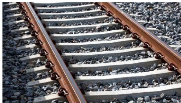
Konventionellt spår med sliprar liggande i ballast.
