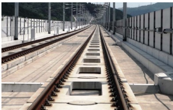
Fixerat spår på betongdäck.
